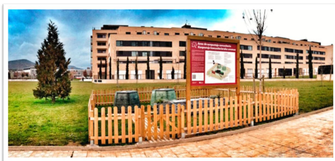
Ejemplo de área de Compostaje Comunitario: Panel Informativo y adecuación del espacio para evitar que se embarre. Modelo de área construido en madera.
